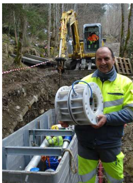
↑ Pose de la picocentrale avec Jean-Marc agent d'exploitation
