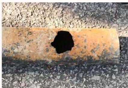
← Remplacement d'une conduite percée
